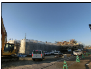
建築工事(型枠等)
