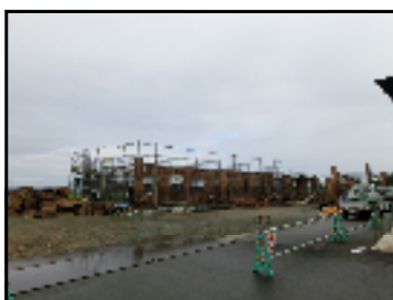
建築工事(鉄筋等)
