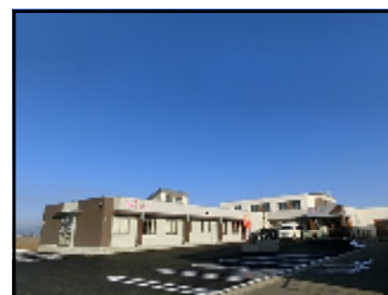
建築工事(完成)
