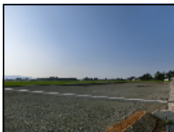
造成工事(完成)
