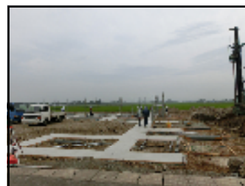
建築工事(基礎)
